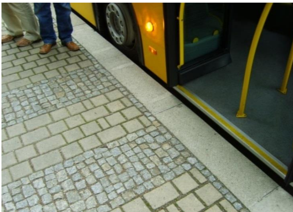
Rys. 5.3.1.3.2.2. Strefa wejściowa – inny rodzaj nawierzchni naprzeciwko pierwszych drzwi autobusu (źródło: opracowanie własne)
