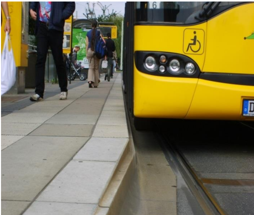
Rys. 5.3.1.3.2.1. Zalecane ukształtowanie krawędzi peronowej. (źródło: opracowanie własne)
