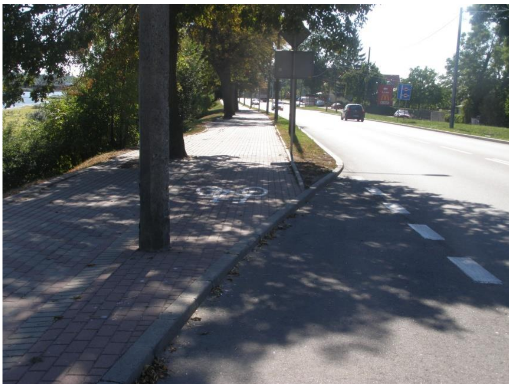
Rys. 2.3.4. Droga dla rowerów o skrajni zwężonej poprzez latarnię, zakończona dodatkowo wysokim krawężnikiem w miejscu zatoki przystankowej jako przykład niedopuszczalnego standardu infrastruktury rowerowej (Malbork, ul. Wałowa) (źródło: opracowanie własne)
